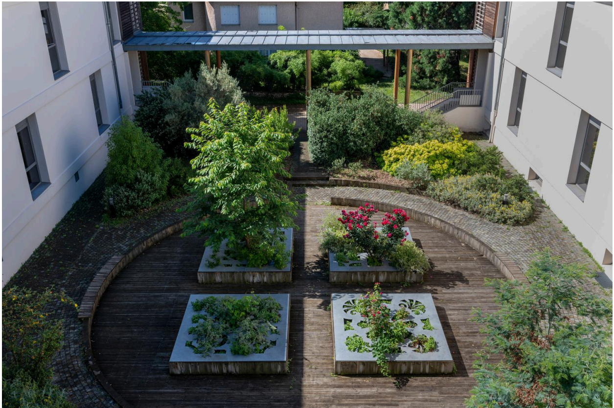
Vue d'ensemble en hauteur.
