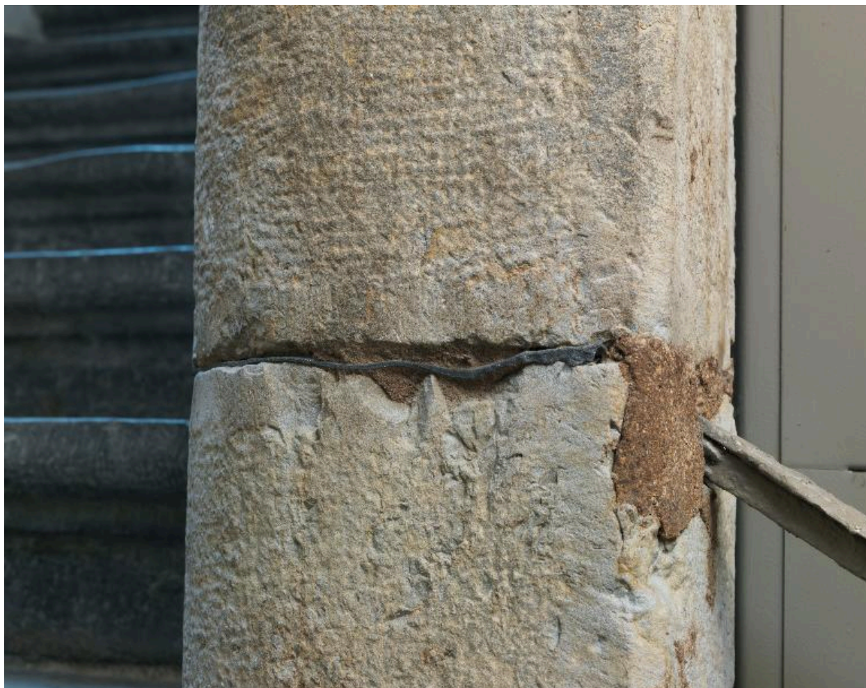
L'escalier : détail d'une cale métallique visible dans l'un des noyaux
