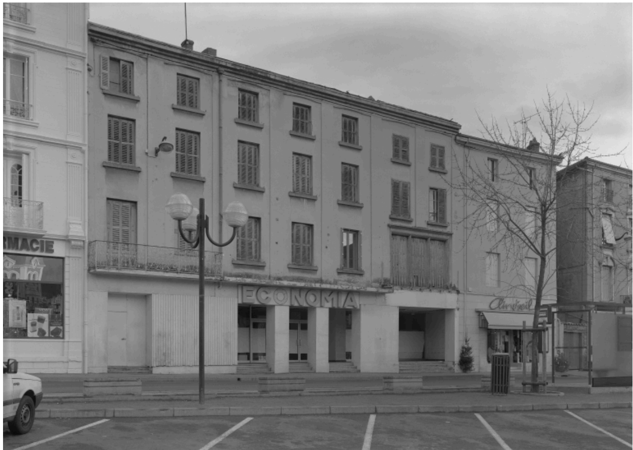
Vue de l'immeuble situé au 7 rue de Lyon (vers 1840), depuis la place de l'Hôtel de Ville, de l'ouest.
