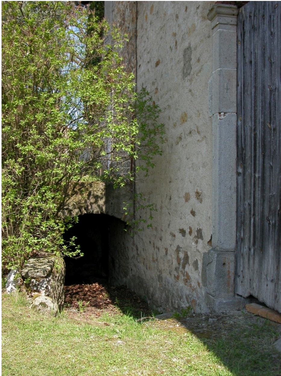
Vue de l'entrée du couloir d'accès à la cave.
