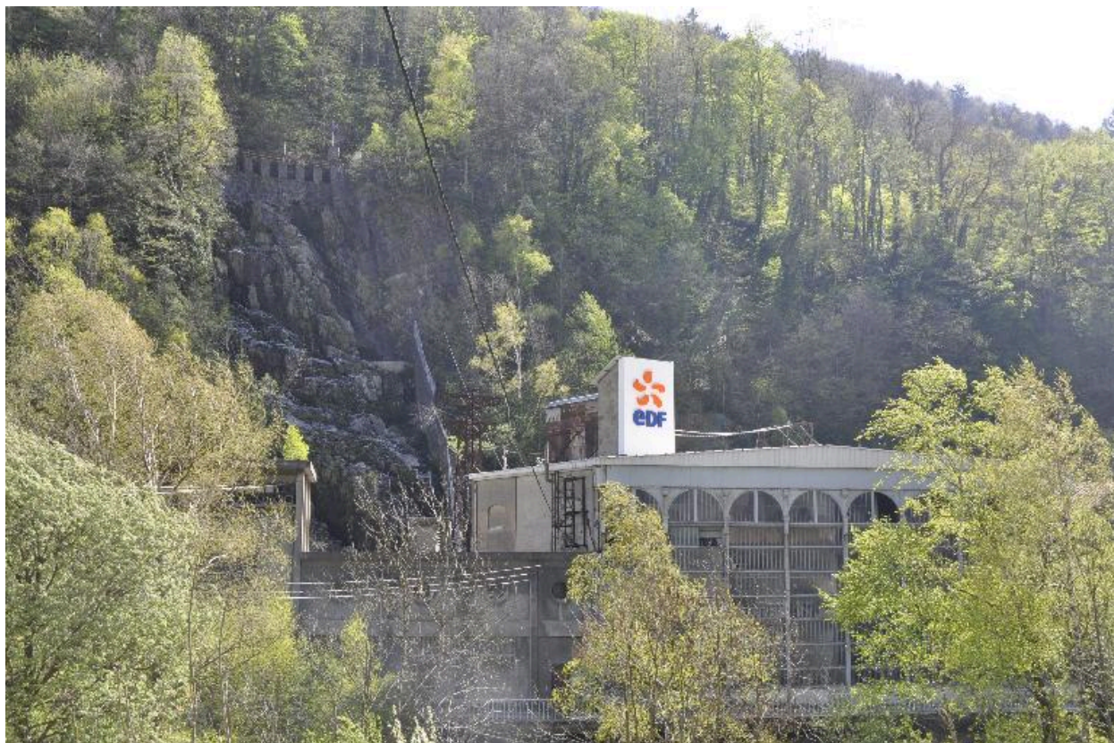
Vue de la centrale
