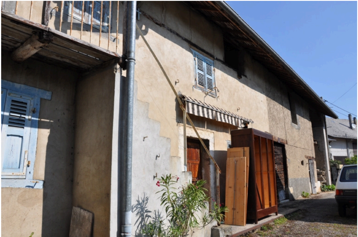
Vue de l'ensemble logement et grange au nord-est du moulin, 2009.
