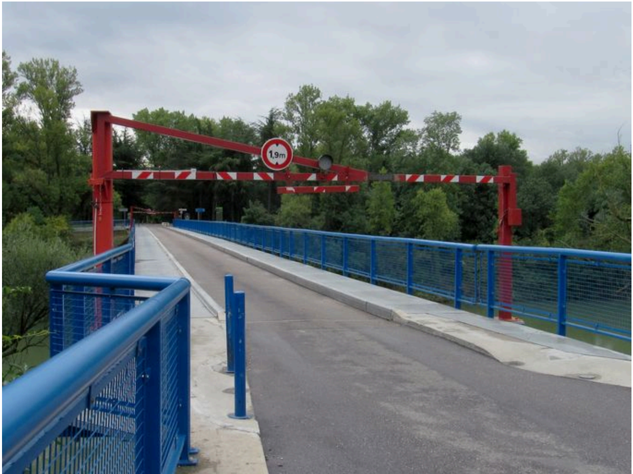
Chaussée (depuis la rive droite)
