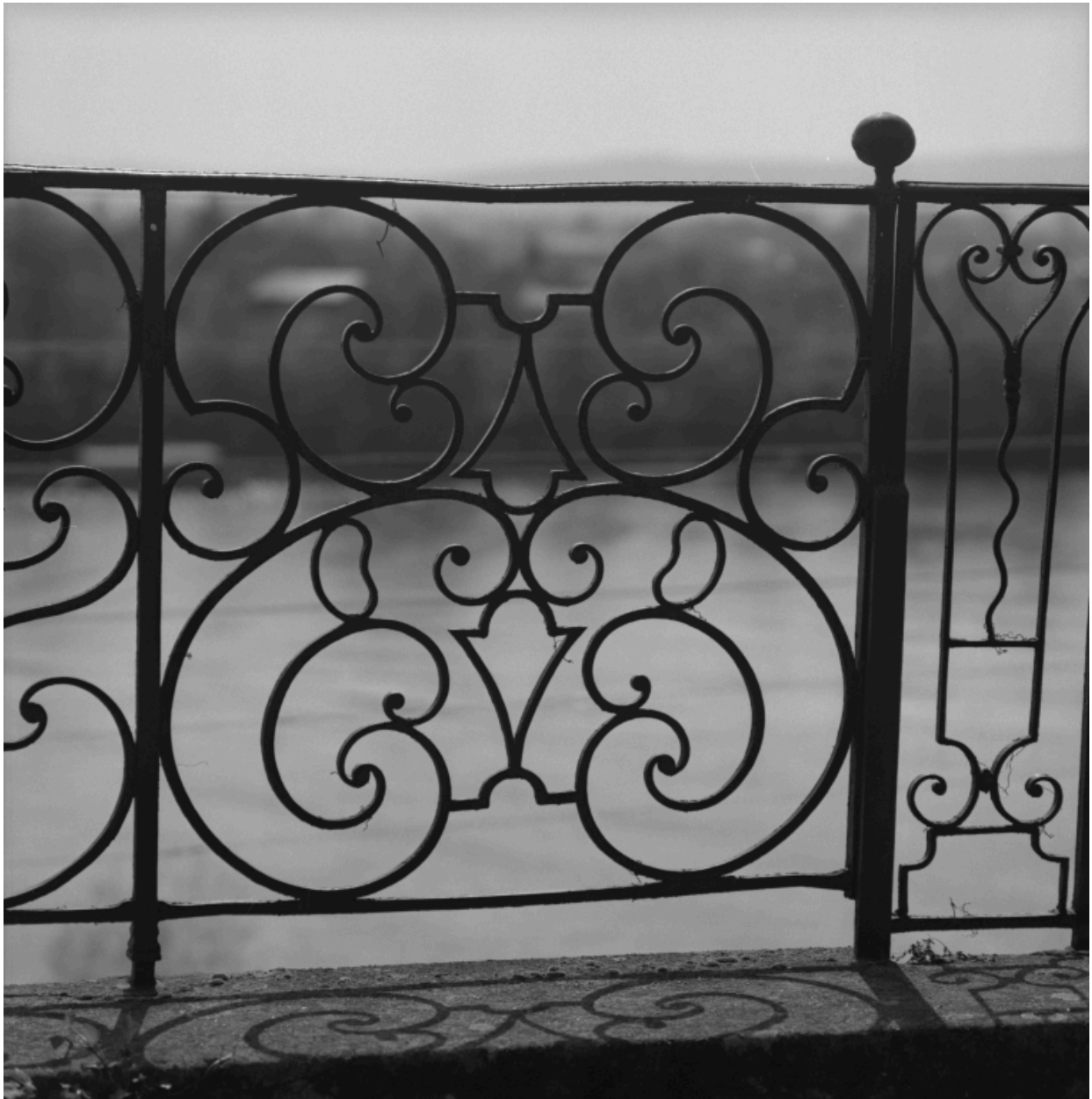
Garde-corps de la terrasse : Panneau latéral du décor central.
