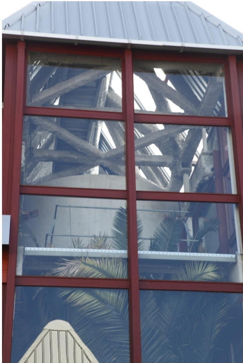
Bâtiment A, façade sud. Serre thermique, poutres tridimensionnelles, façade ouvrante et toiture en couverture bardage aluminium.
