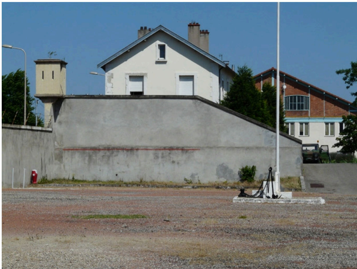
Vue nord-ouest et mirador
