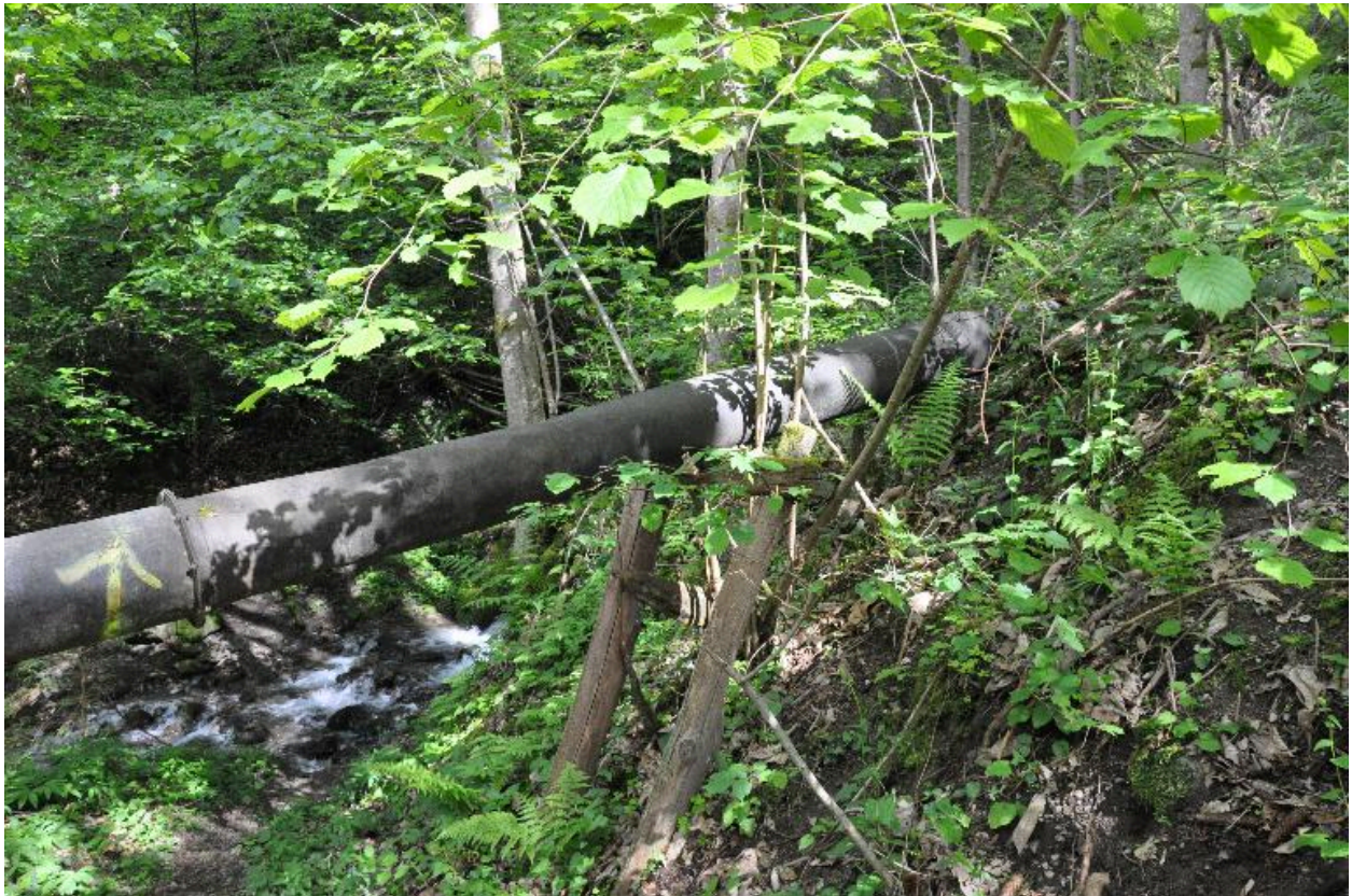
Vue de la conduite.
