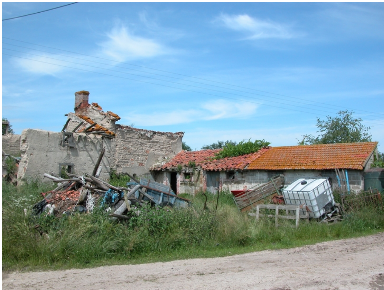
Vue de l'angle nord-est de la cour : logement, porcherie.
