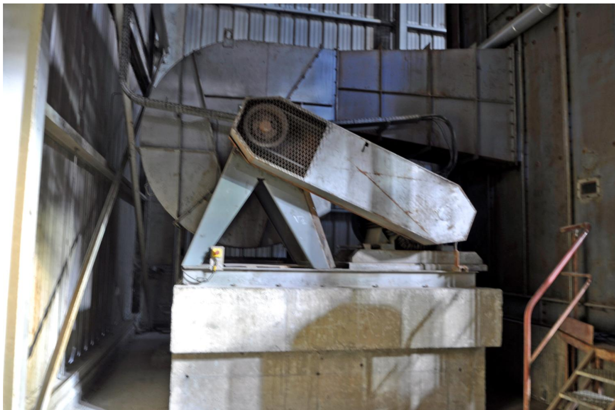
Vue de l'intérieur des ateliers
