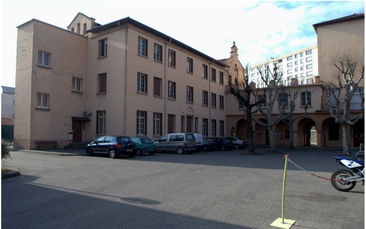
La cour est et le bâtiment principal, vue d'ensemble depuis le nord-est
