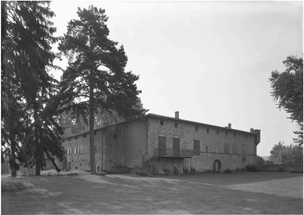
Elévation postérieure sur parc du corps de passage et aile droite.
