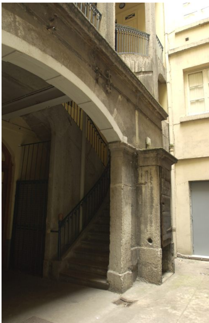
La cour, partie nord-est : puits et départ d'escalier
