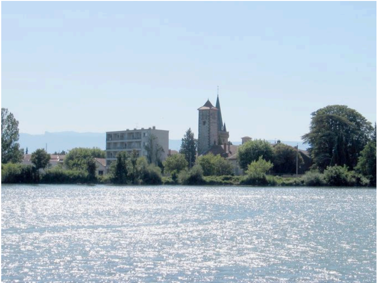
Vue du site supposé depuis la rive gauche (vers La Roche-de-Glun)
