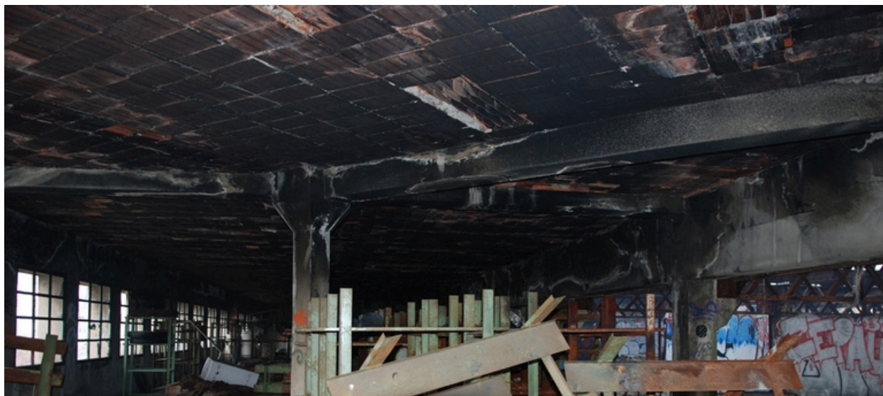
détail poutre béton centrale
