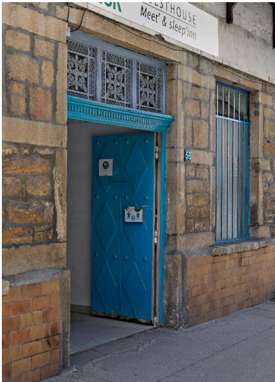
Vue du rez-de-chaussée et de la porte cochère
