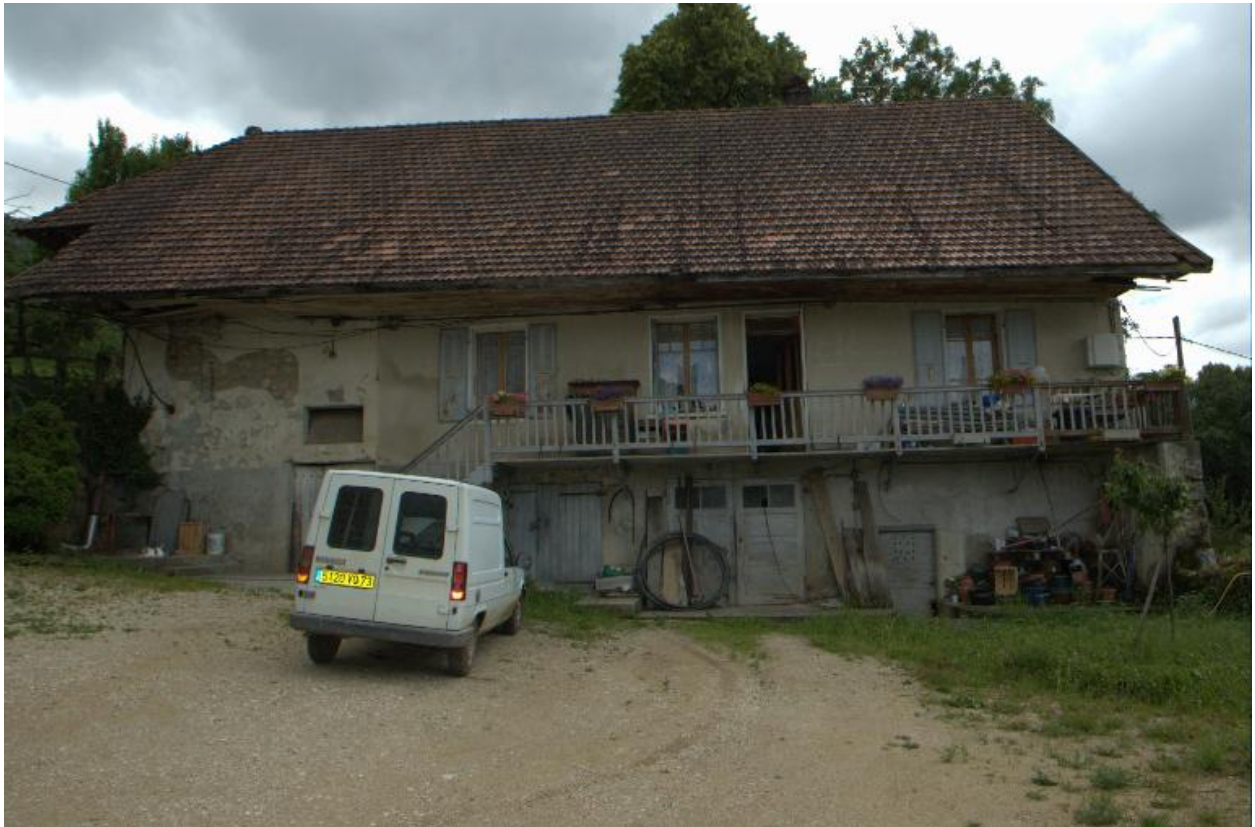
Vue d'ensemble de face de la façade principale sur cour.
