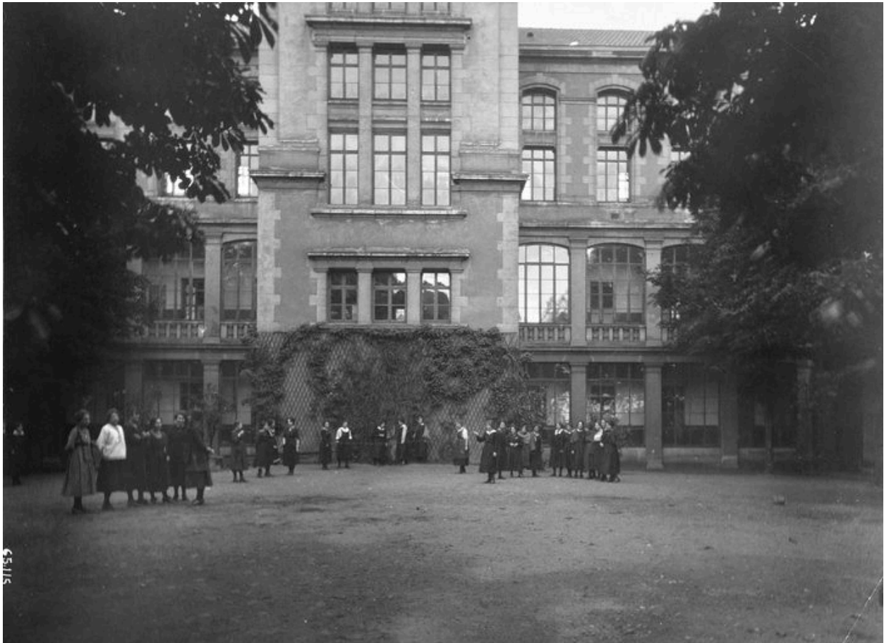
Vue de l'élévation postérieure depuis la cour : la galerie de l'étage des classes a été fermée par un vitrage (Arch. dép. Rhône, 1 T 1275, photographie).
