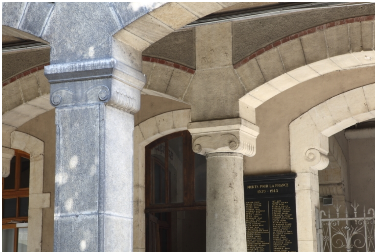
Cour H. Colonnes, piliers et chapiteaux au niveau de l'accueil.
