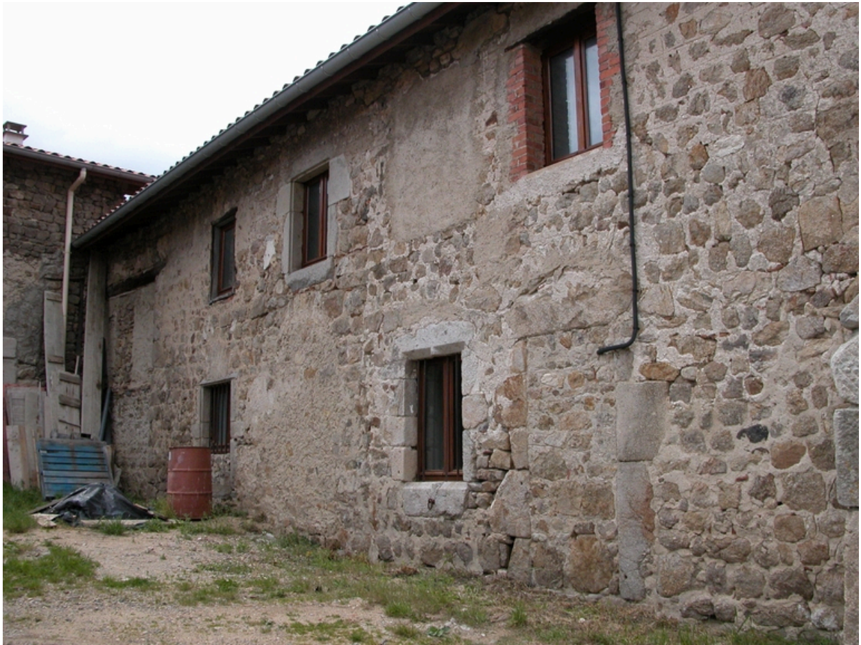
Vue du logis ancien, depuis le sud-est.
