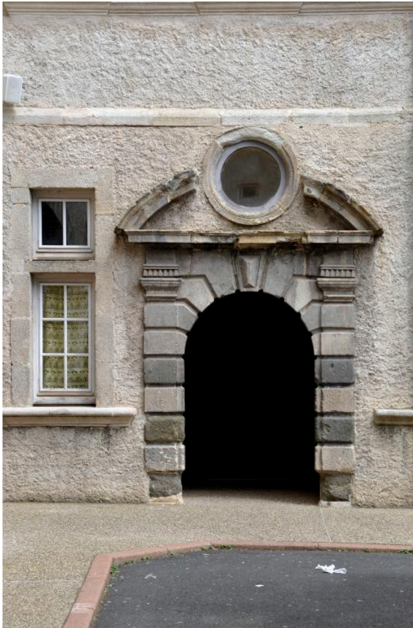
Cour 2 : pavillon est, détail de la porte
