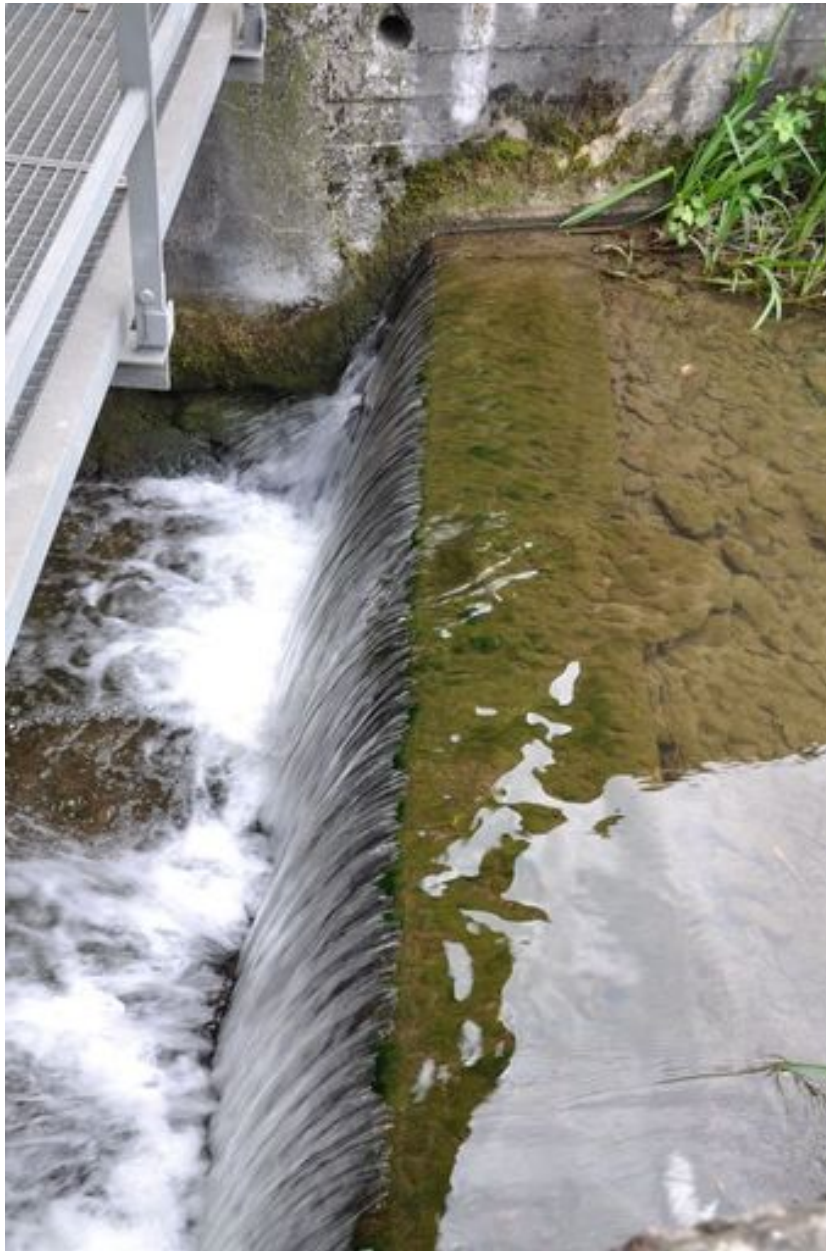
Détail du seuil de l'ancienne scierie hydraulique
