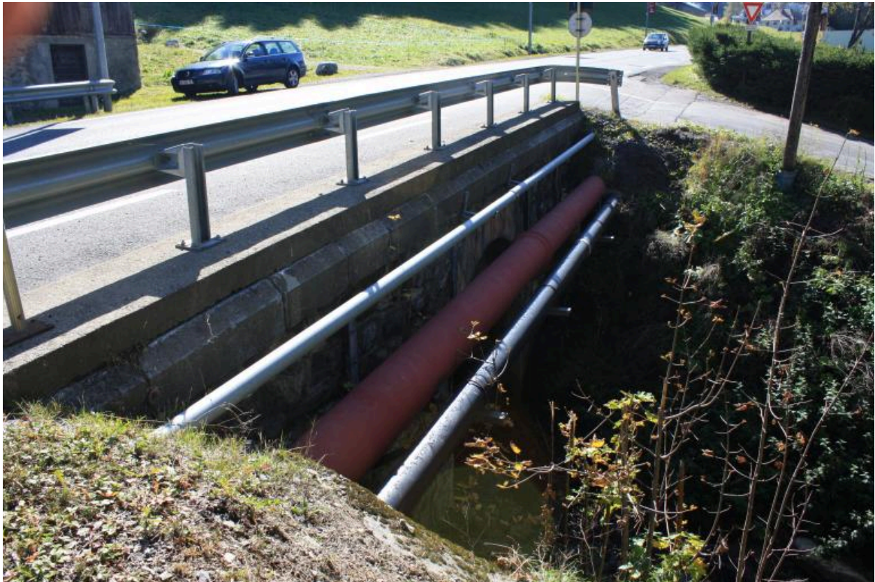
Pont du petit Nant, chaussée et gardes corps
