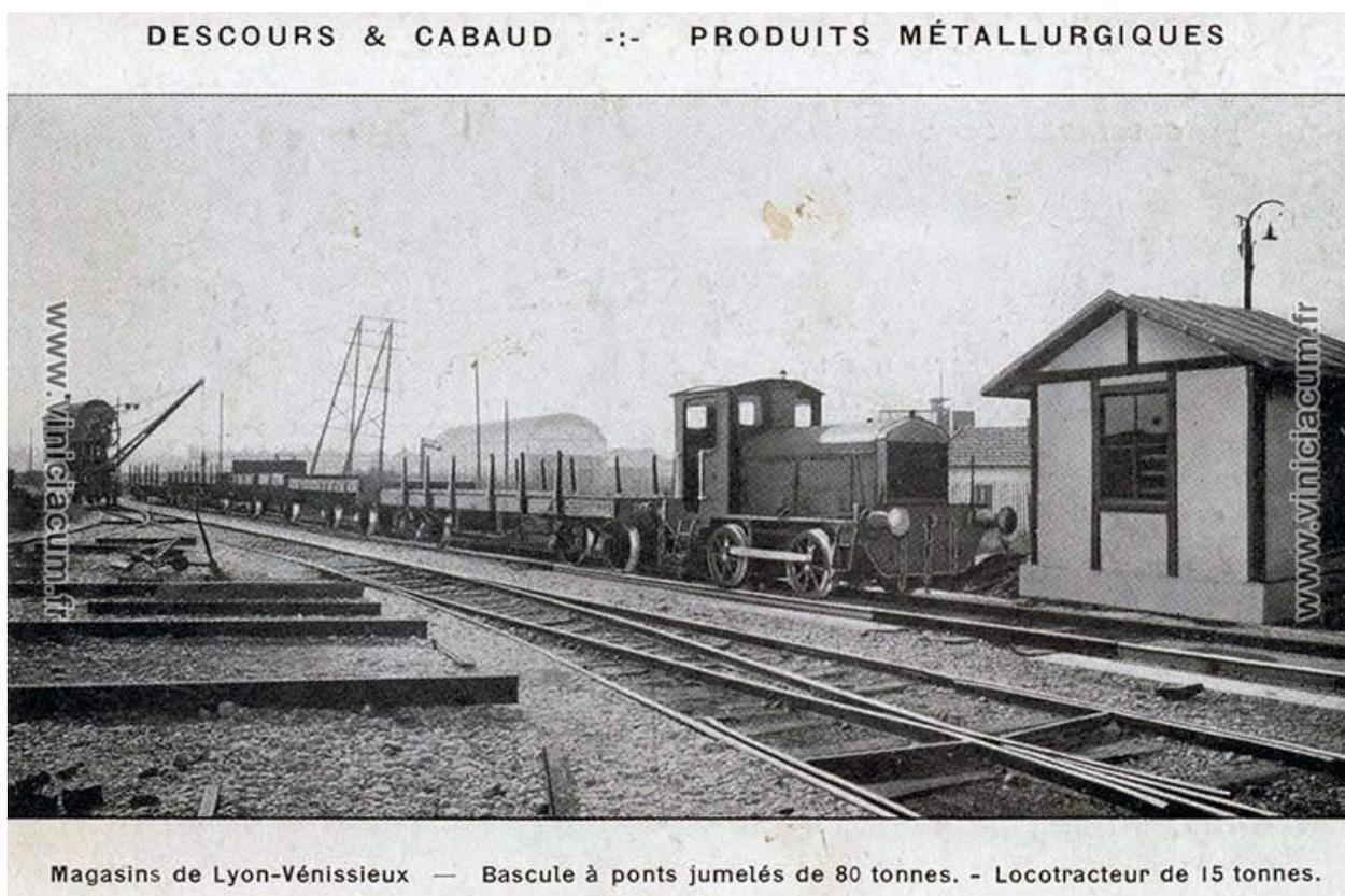
Descours et Cabaud - Produits métallurgiques - Magasins de Lyon-Vénissieux - Bascule à ponts jumelés de 80 tonnes - Locotracteur de 15 tonnes (Association Viniciacum)
