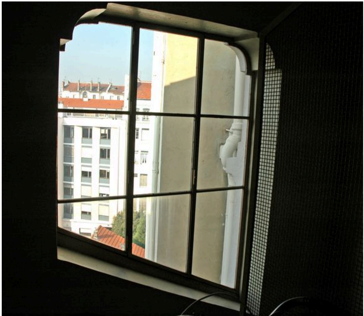
Fenêtre éclairant la montée d'escalier
