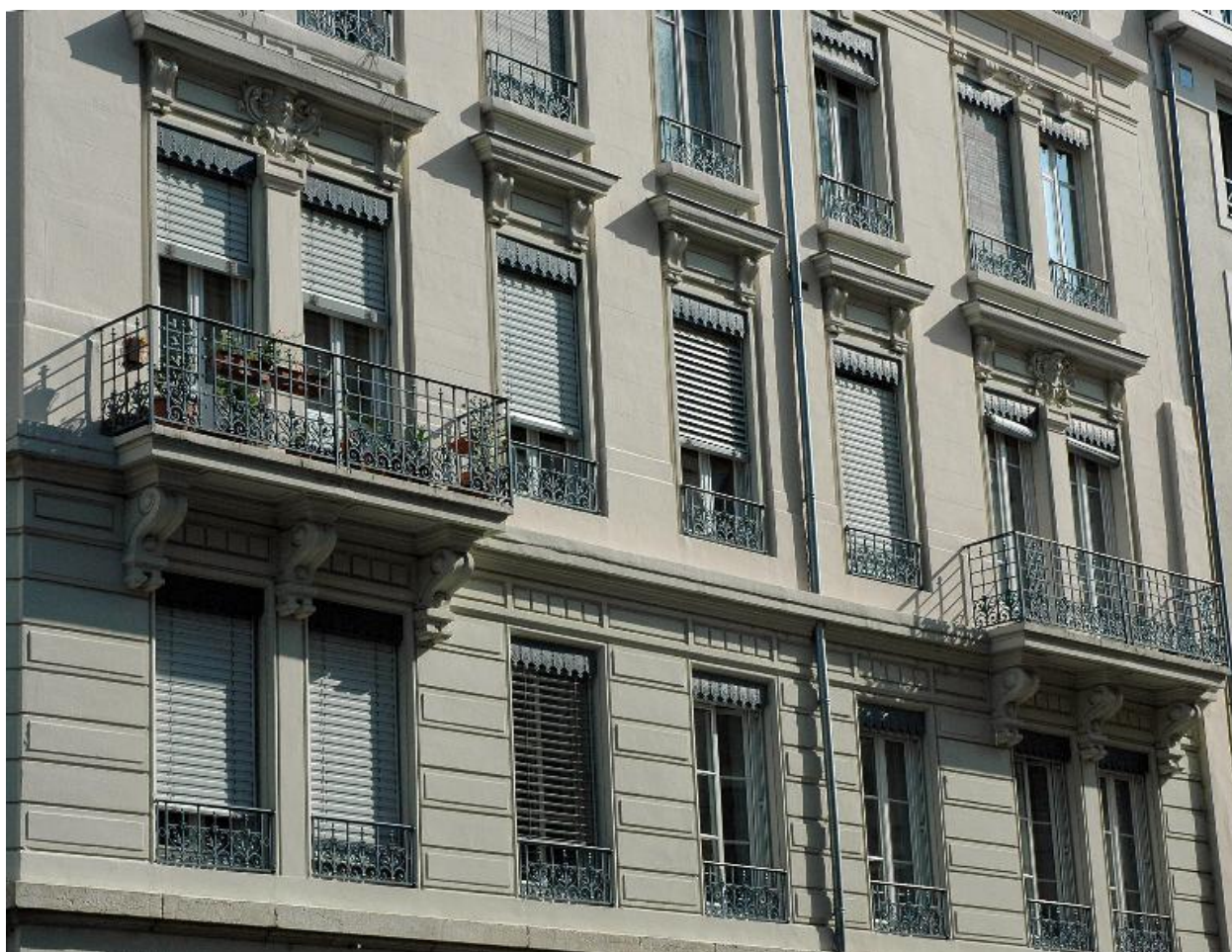
Elévation sur rue Reinach : vue rapprochée
