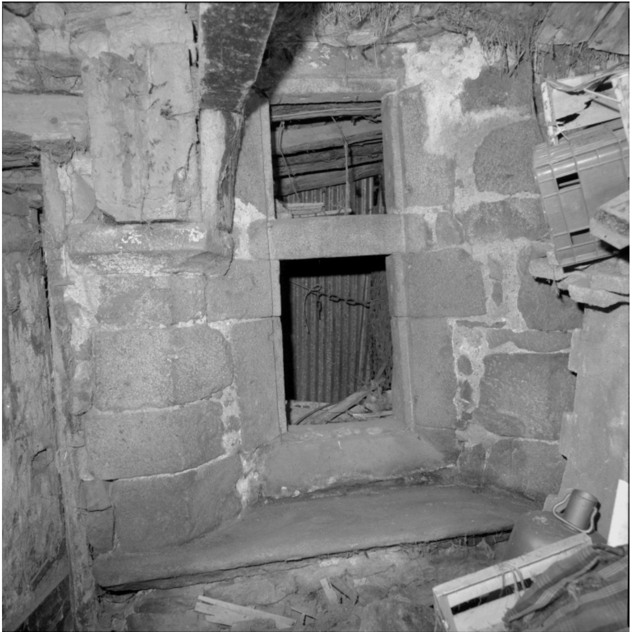
Intérieur du logis, détail d'une baie à meneau accolée au départ du linteau de la cheminée.
