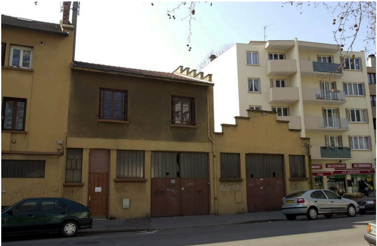
Atelier et bureau de la partie droite
