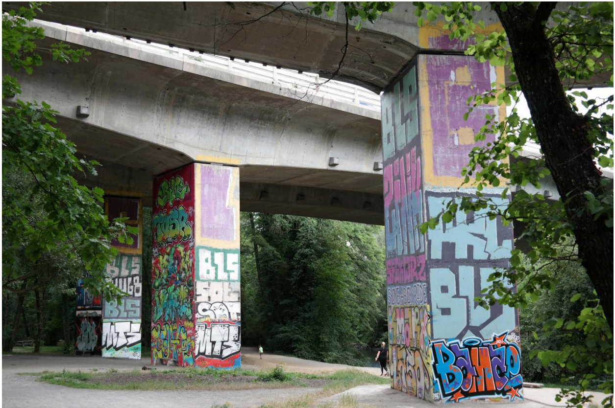
Viaduc de Cran, vue de la rive gauche en dessous
