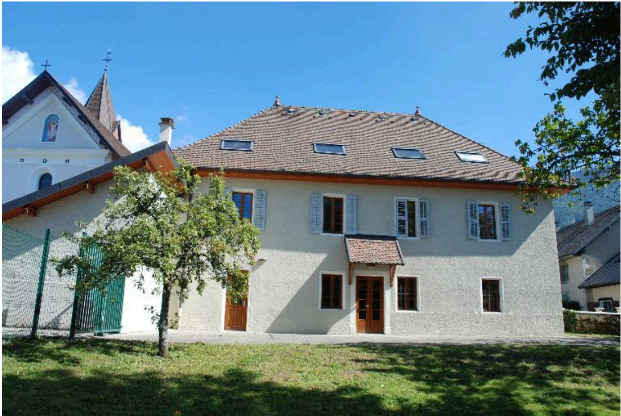
Vue d'ensemble depuis l'ouest : façade sur jardin.
