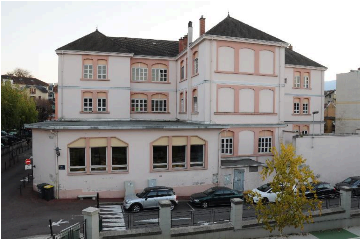
Vue d'ensemble : façades postérieures
