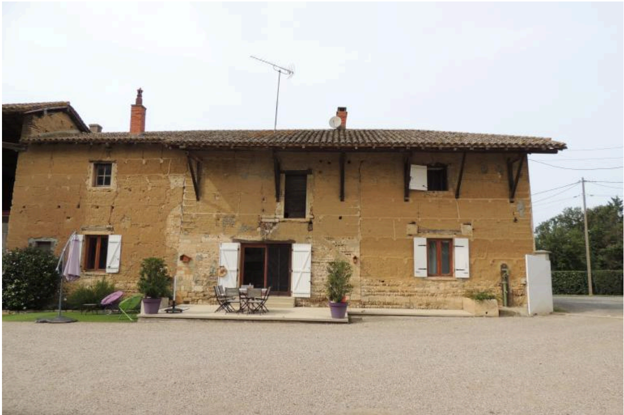
Bâtiment nord, façade sud.
