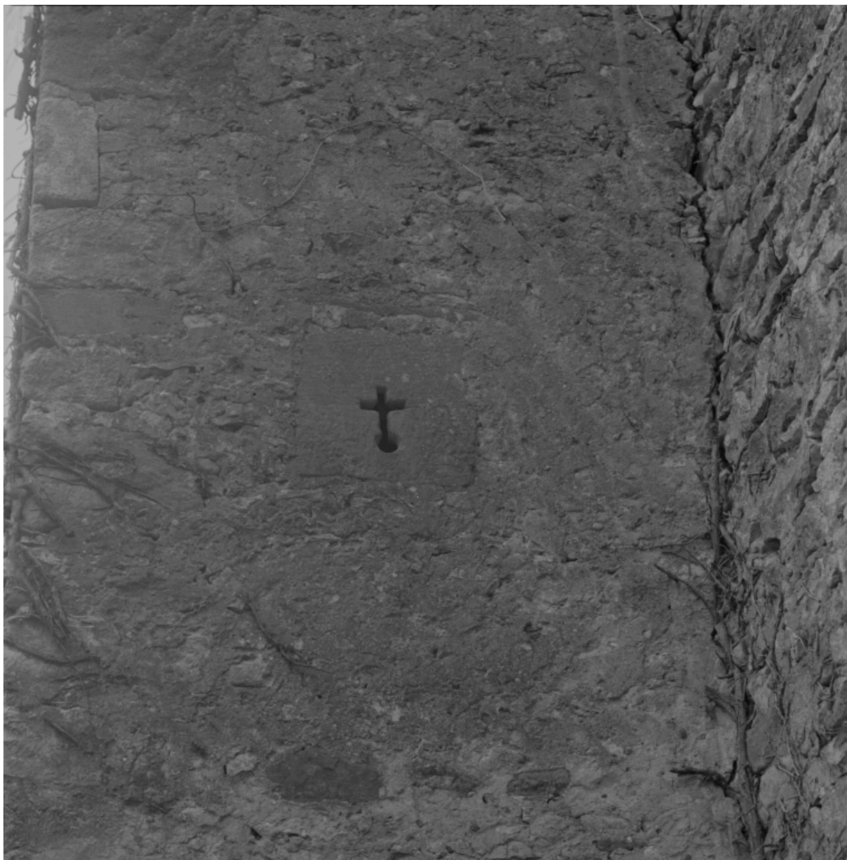
Détail de la tour sud-est : archère canonnière en croix.
