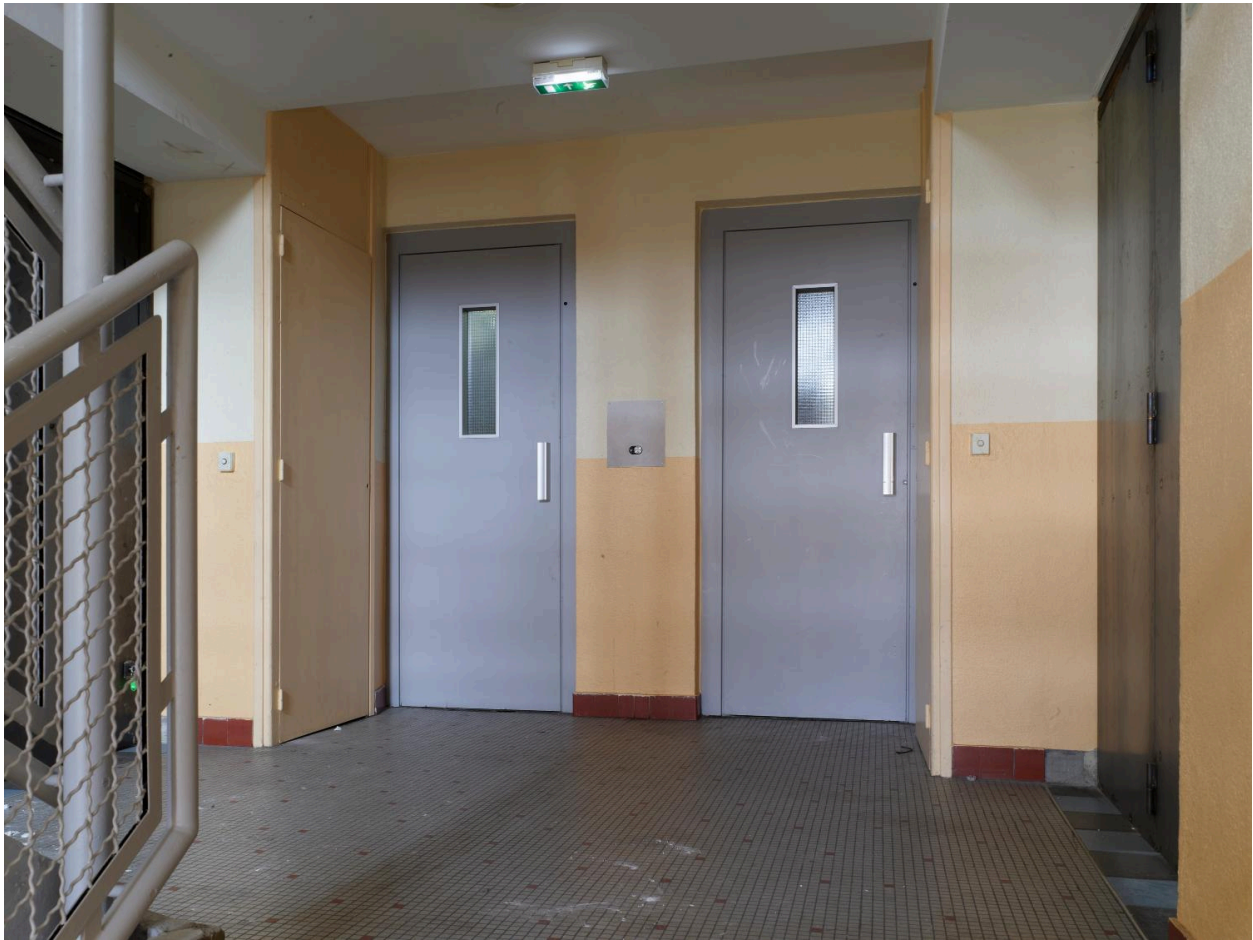
Intérieurs, espaces de distribution. Immeuble du 1-3 allée des Dômes. Cage d'escalier et d'ascenseurs. Un des paliers du 13e étage.
