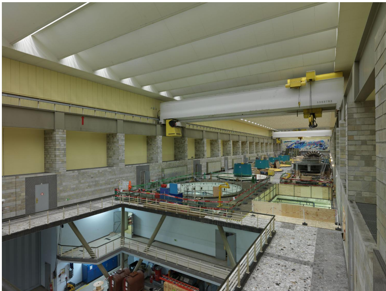
Vue d'ensemble de la salle des machines, au premier plan le hall de manutention puis le groupe 6 en cours de rénovation, partiellement démonté
