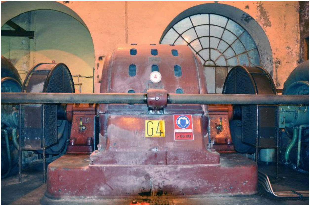
Alternateur du G4 (centrale de Livet)
