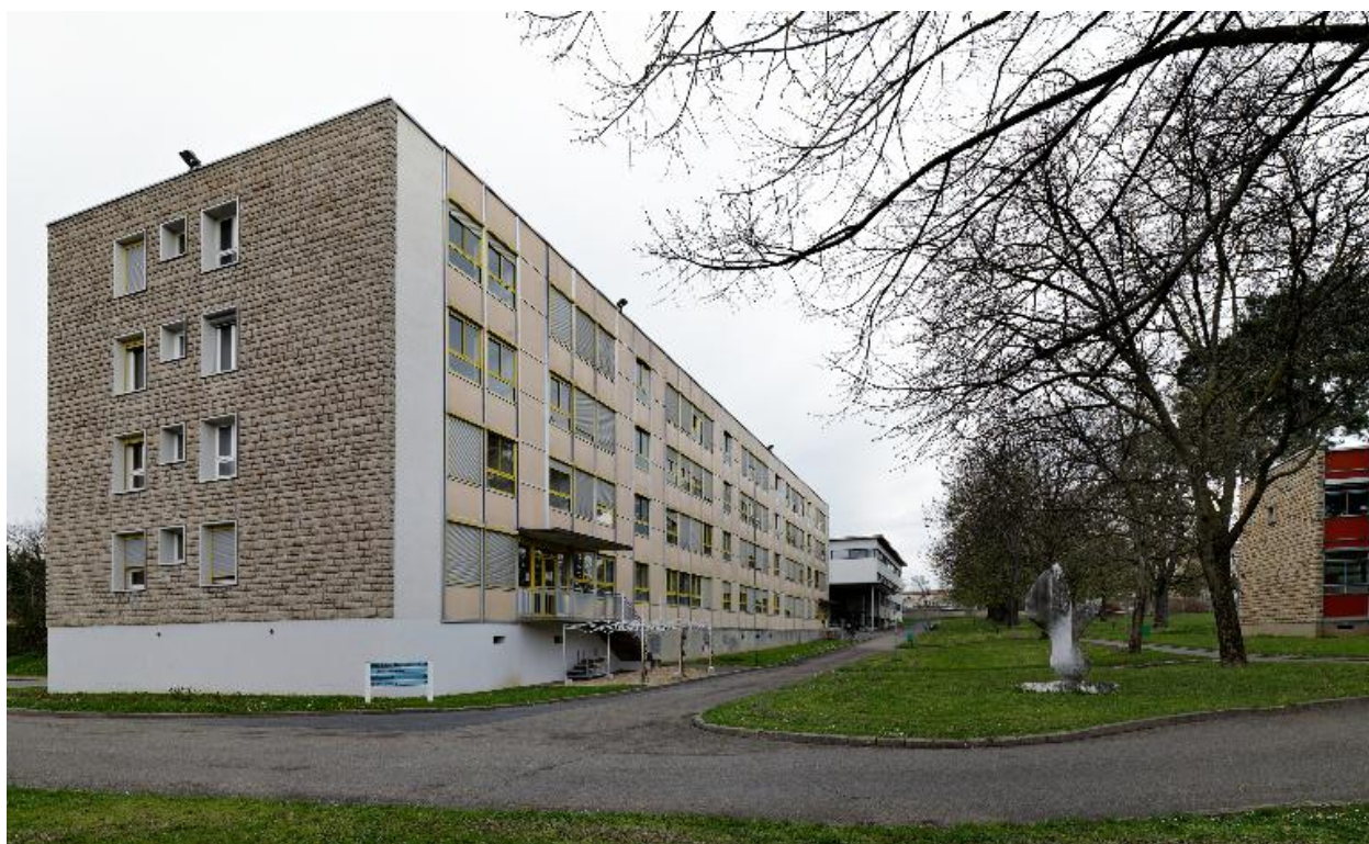
Internat, vue d'ensemble depuis le sud-est
