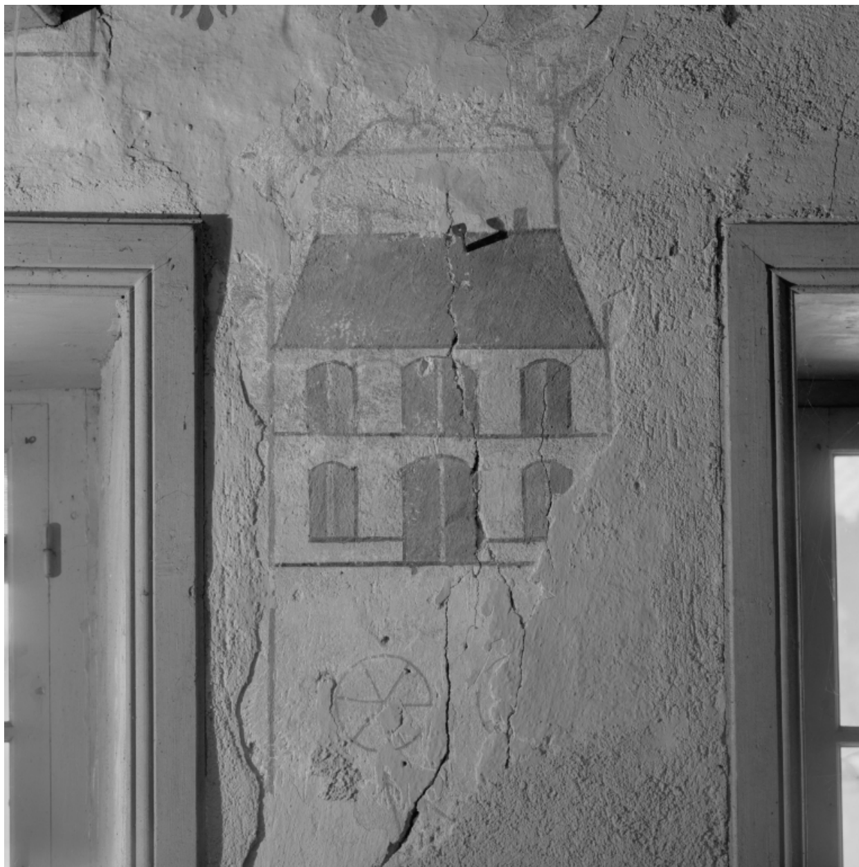
Vue intérieure de la salle du premier logis : détail des décors peints.
