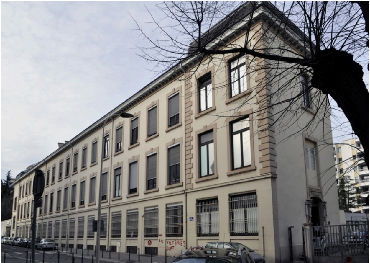
Vue d'ensemble sud-est
