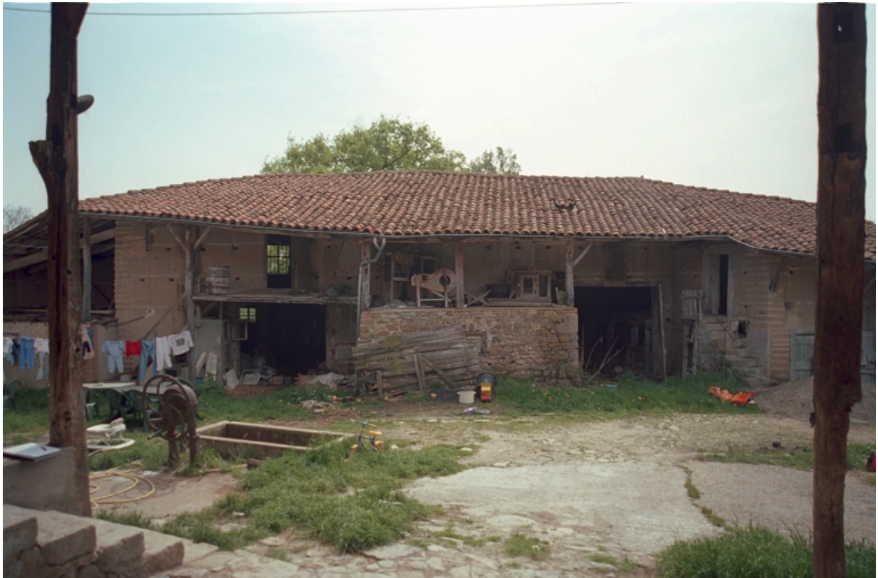
Premier ensemble. Bâtiment sud-est : vue d'ensemble de la façade nord depuis la cour.
