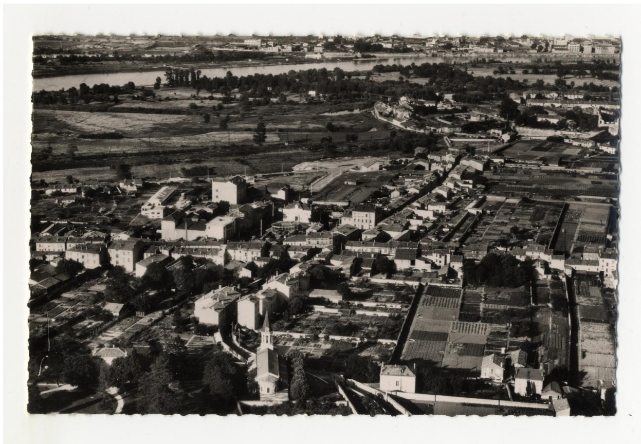
Vue générale aérienne, 1940-1950 (AC Pierre-Bénite : 28037)
