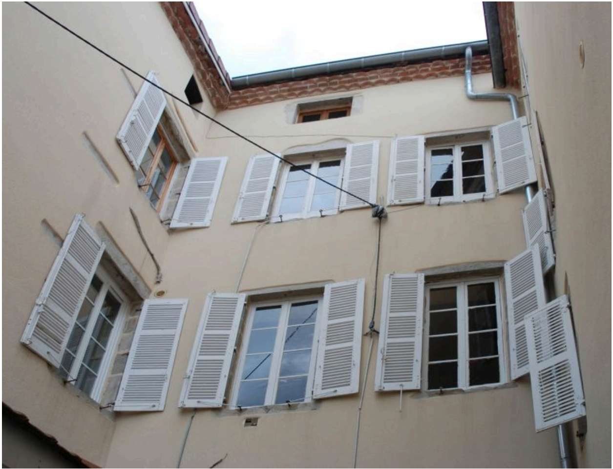
Elévations sur cour après restauration.
