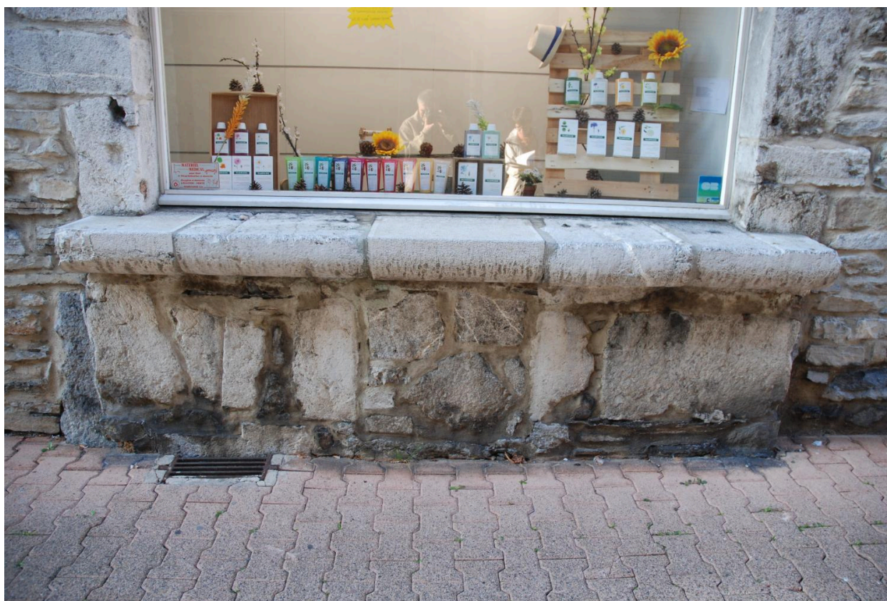
Maison, immeuble, 26 rue Louis Blanc-Pinget (2018 E1 278 à 281). Détail de l'élévation sur la rue Louis Blanc-Pinget : banc.
