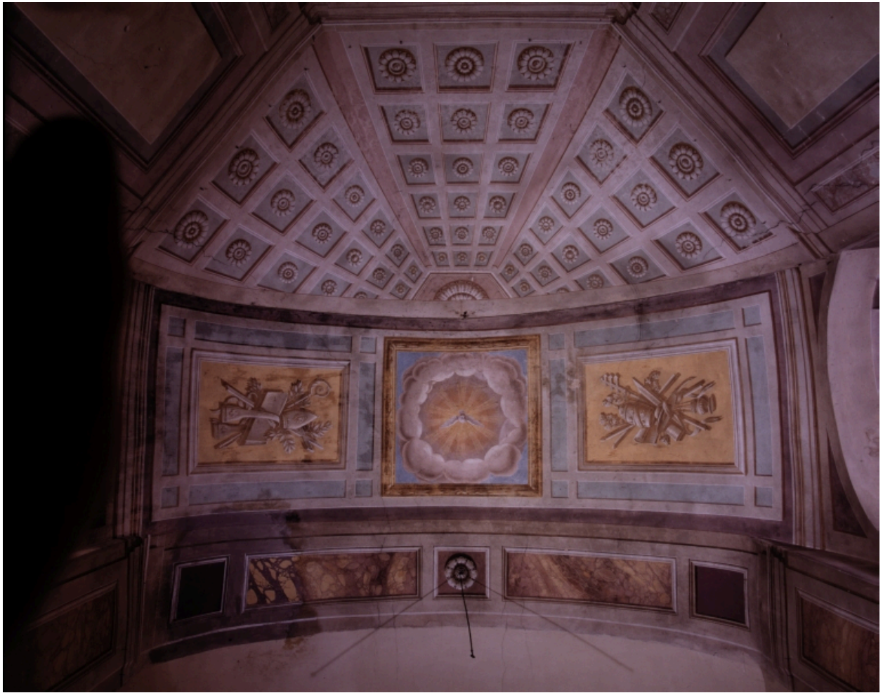
Voûte, vue d'ensemble.
