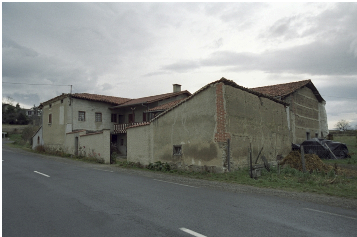
Saint-Sixte, la treille (1987 A1 46). Vue d'ensemble de la ferme.
