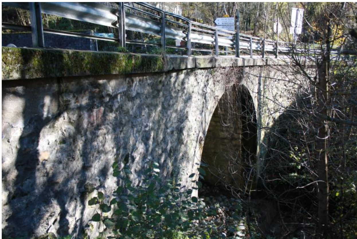
Pont du Biot, face aval
