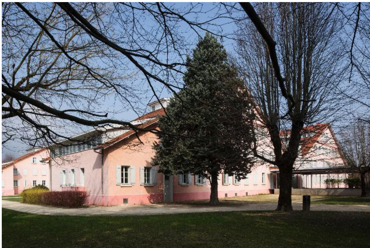
Bât. A : vue depuis le sud-est
